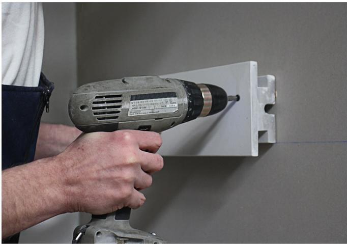
При необходимости произвести корректировку изгибов эластичных деталей, зафиксировав контакт с несущей поверхностью шурупами.
