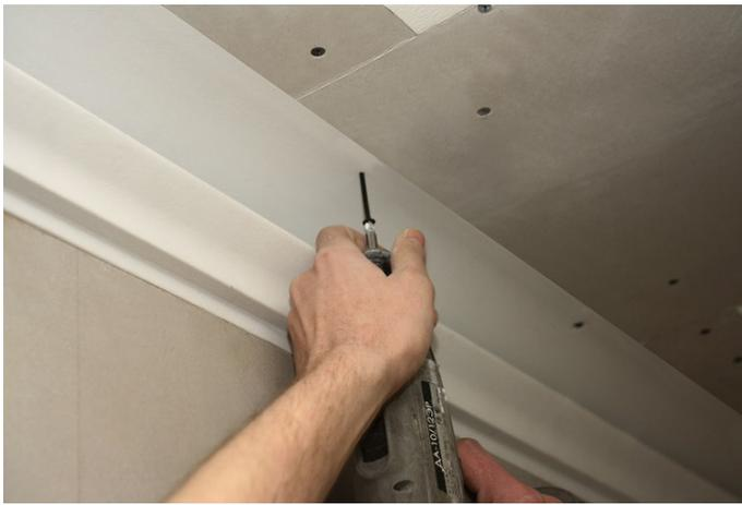
При необходимости произвести корректировку изгибов эластичных деталей, зафиксировав контакт с несущей поверхностью шурупами для металлопрофиля
