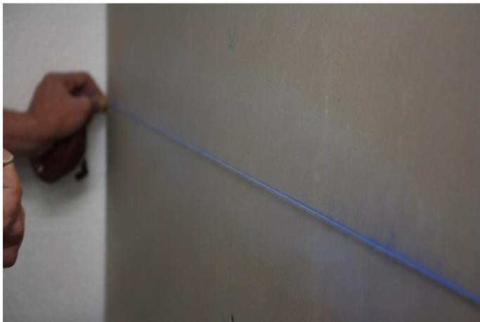
С помощью уровня и отбивочного шнура делаем разметку на поверхности стены для монтажа настенного карниза.
