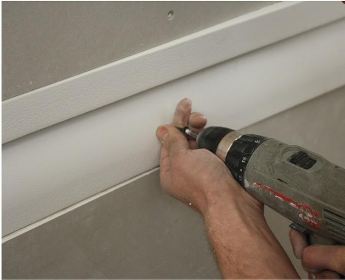
При необходимости произвести корректировку изгибов эластичных деталей, зафиксировав контакт с несущей поверхностью шурупами для металлопрофиля
